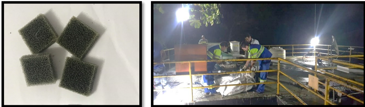
Figura 3 - Aplicação da Mídia de Poliuretano catalisada com compostos de carbono
